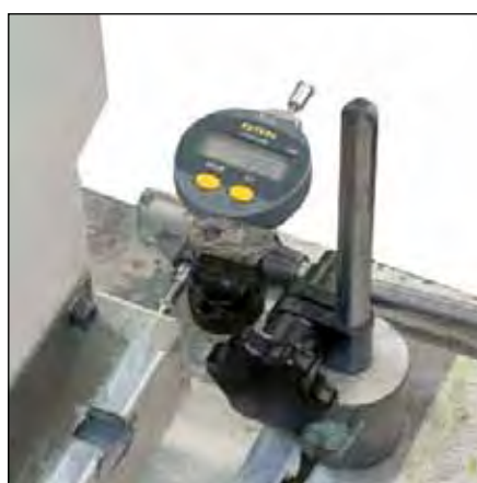
Mesure du déplacement vertical d'un élément
